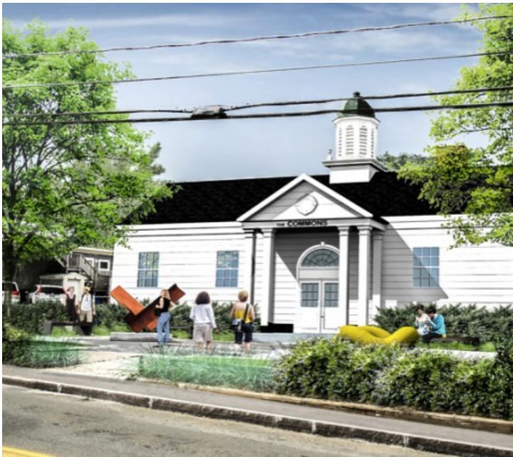
Provincetown Commons post-renovation
