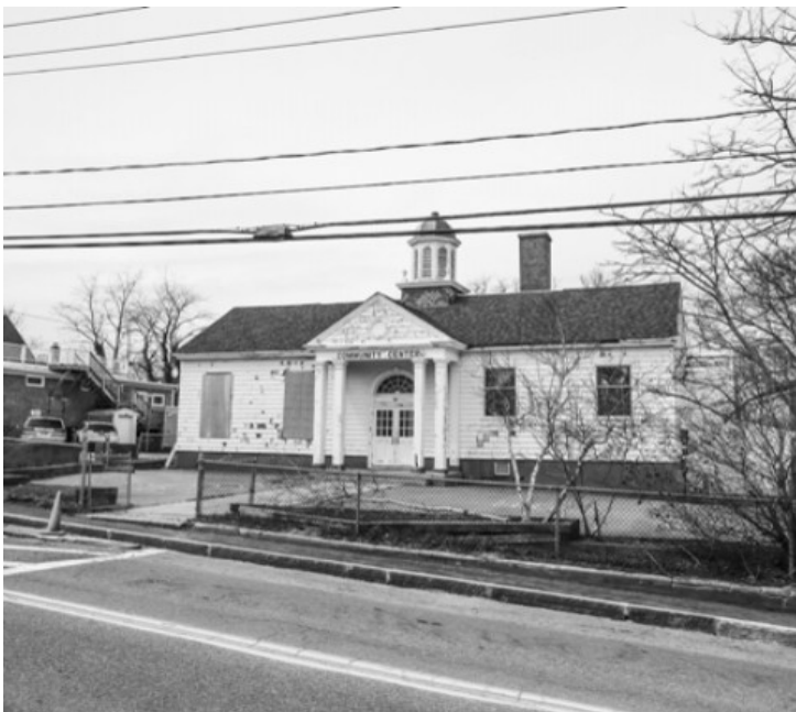
Provincetown Commons pre-renovation
