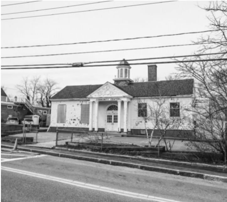
Provincetown Commons pre-renovation
